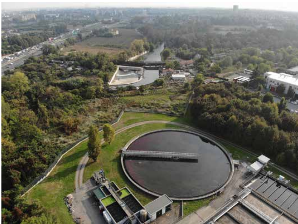
Le aree a Sud dell'impianto CAP, lo scolmatore del Lambro ed il ponte del Naviglio Martesana
