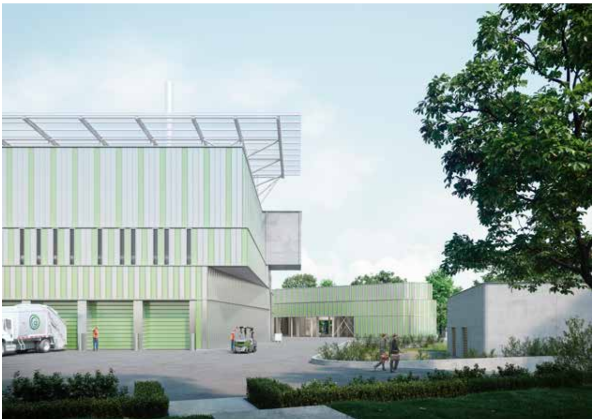
L'avanfossa fanghi e i biofiltri visti dagli uffici
