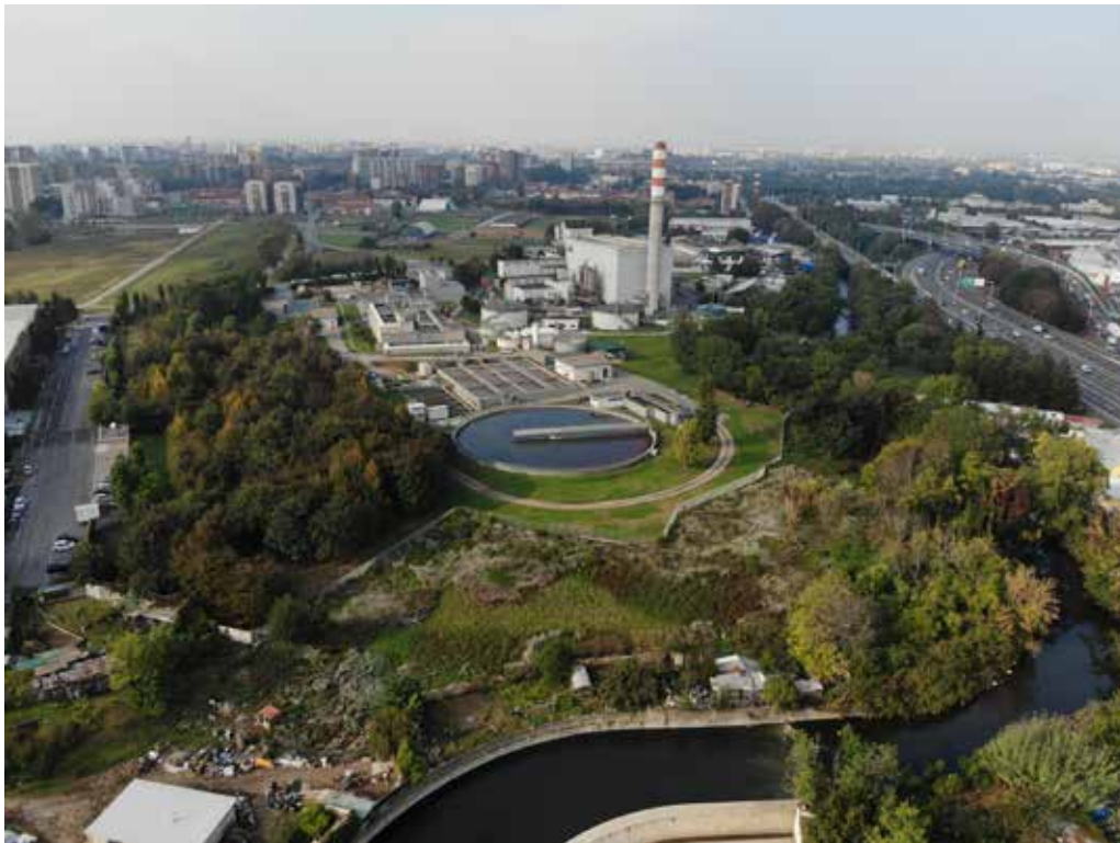
Veduta generale degli impianti e dell'intorno
