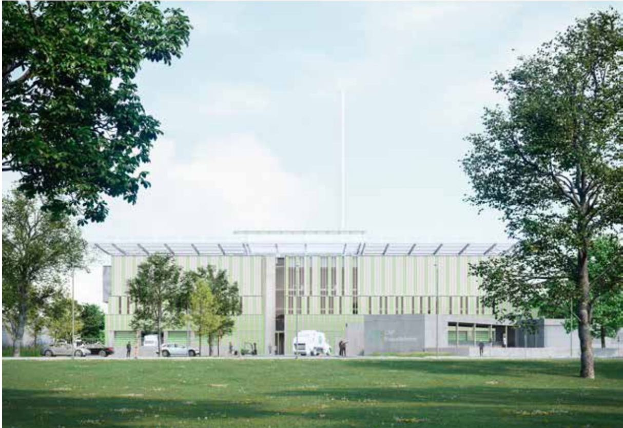
La realizzazione dell'avanfossa permette di definire la nuova fronte dell'edificio e di contenere le dispersioni di odori: i mezzi scaricano in ambiente chiuso attrezzato con un impianto di aspirazione per l'eliminazione degli odori
