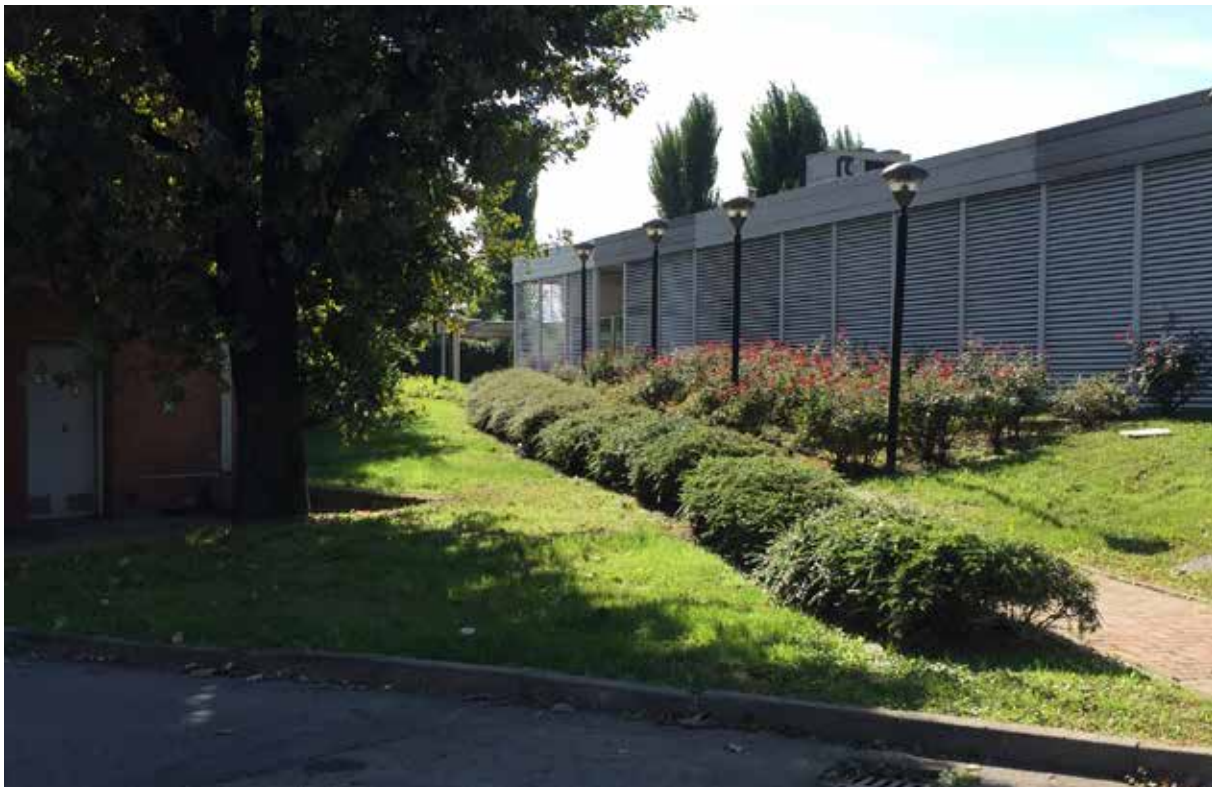
L'attuale edificio ad uso uffici da ristrutturare
