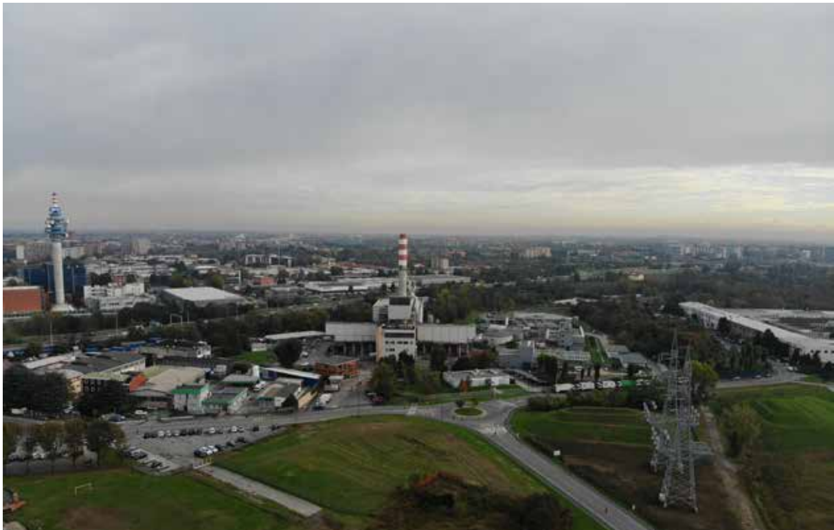
Le aree verdi a perimetro dell'impianto
